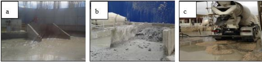
Şekil 74. Atık beton ve beton çamurları, a) Çökeltme havuzu 86 , b) Kurutma alanı 86 , c) Dolum alanı 87
