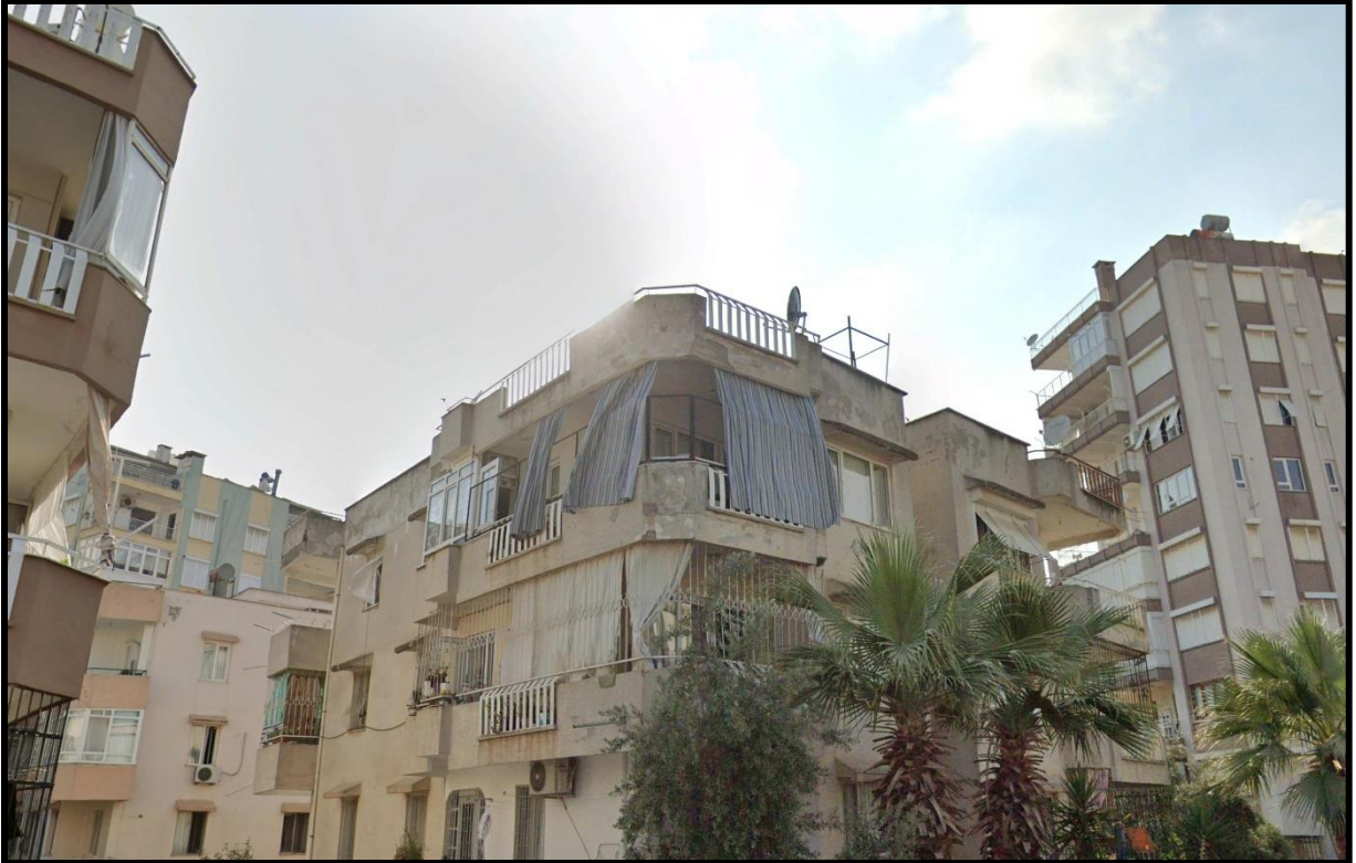
RESİM 8.2864 ADA 7,8,9,10 VE 11 NUMARALI PARSELLERİN İÇERİSİNDE YER ALAN YAPILARIN DURUMU
