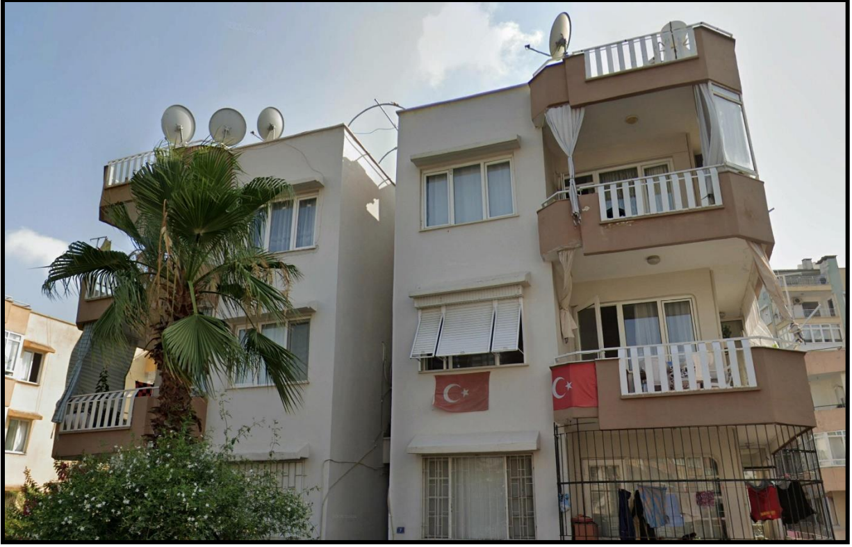
RESİM 7.2864 ADA 7,8,9,10 VE 11 NUMARALI PARSELLERİN İÇERİSİNDE YER ALAN YAPILARIN DURUMU
