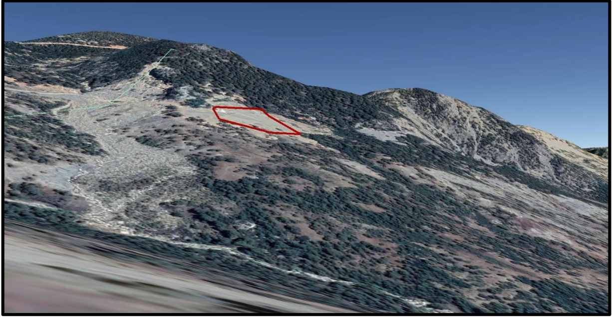
Fotoğraf 3. 146 Ada 3 Parsel'in Batı Yönünden Görünümü
