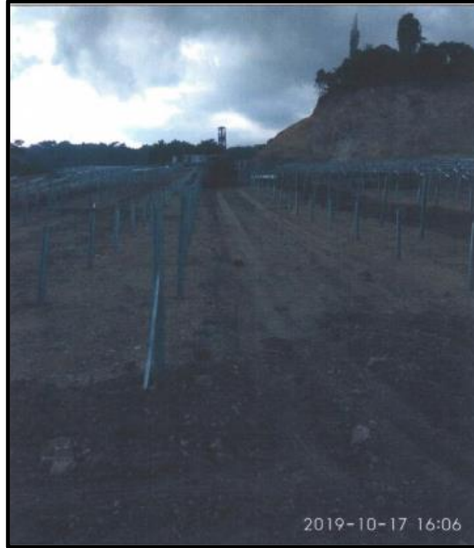
Fotoğraf 4. 146 Ada 3 Parsel'in Mevcut Durumu (GES Panel Ayakları)
