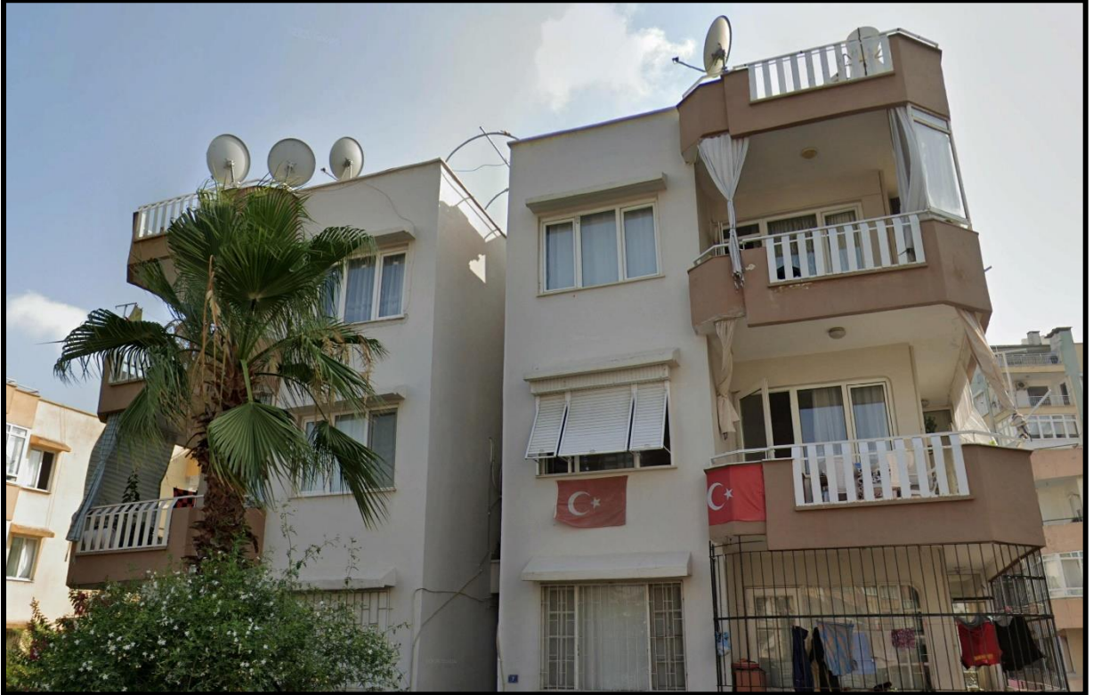
2863 ADA 7, 8, 9, 10 ve 11 PARSELLERİN İÇERİSİNDE YER ALAN YAPILARIN DURUMU
