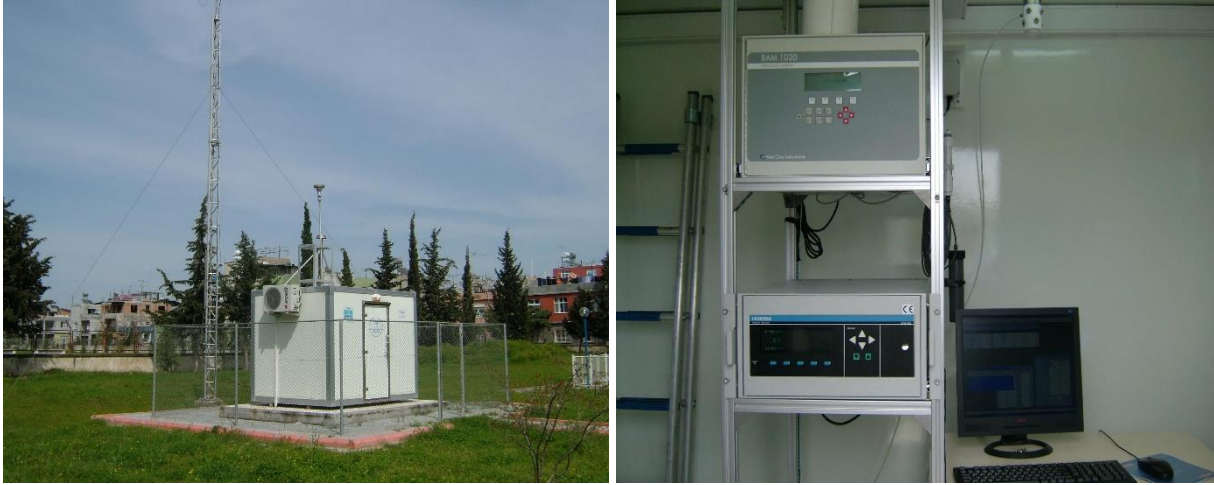
Resim 7. Meteoroloji Hava Kalitesi İzleme İstasyonu
