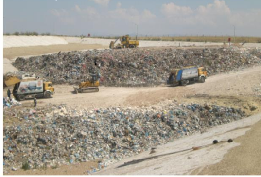
Evsel Atıkların Depolandığı Geçirimsizliği Sağlanmış Lotlar
