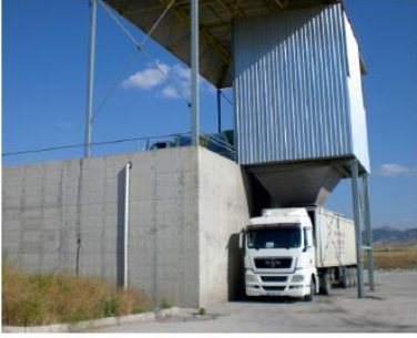
Katı Atık Transfer İstasyonu
