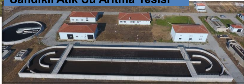
Sandıklı Atık Su Arıtma Tesisi
