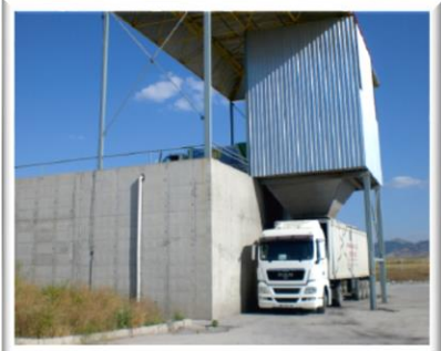
Katı Atık Transfer İstasyonu
