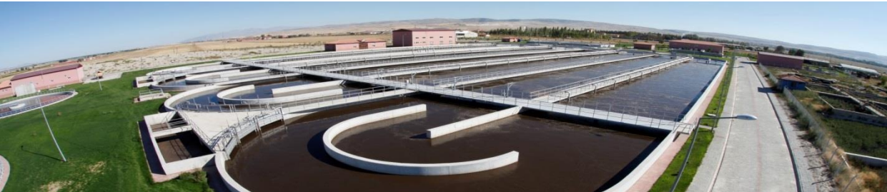
Afyonkarahisar Merkez Atıksu Arıtma Tesisi
