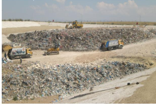
Evsel Atıkların Depolandığı Geçirimsizliği Sağlanmış Lotlar
