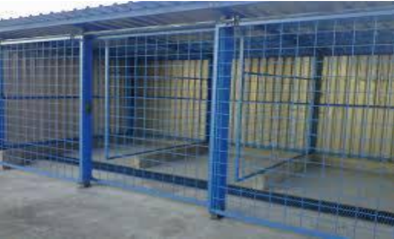
Kilitlenebilen, ızgara kapılı hangar
