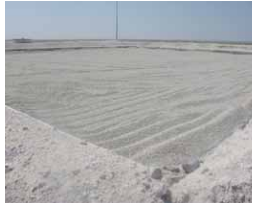
Altinekin Doğal Arıtma Tesisi
