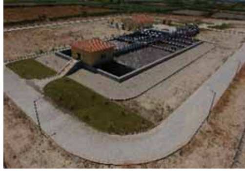
Akköy Atık su Arıtma Tesisi
