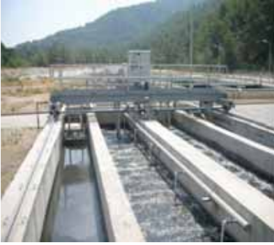
Akyaka Atık su Arıtma Tesisi
