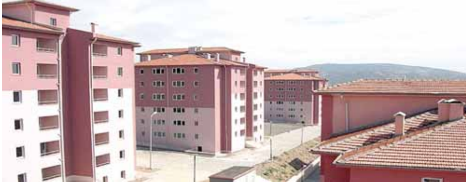
Yozgat - Çekerek 224 Konut ve altyapı inşaatı
