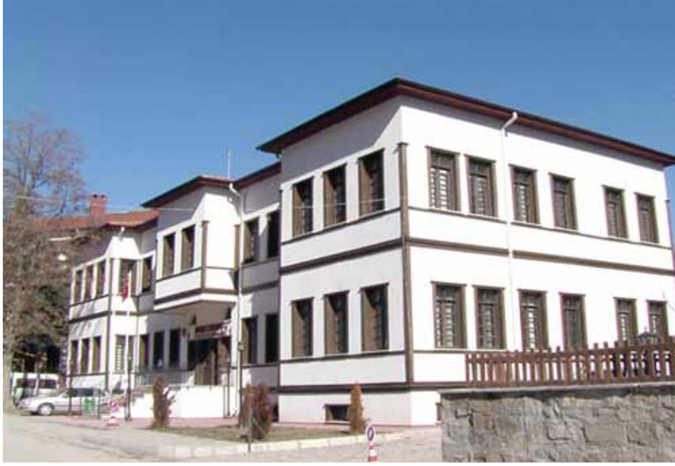
BOLU GÖYNÜK HÜKÜMET KONAĞI(Yapımı Tamamlanan İşler)
