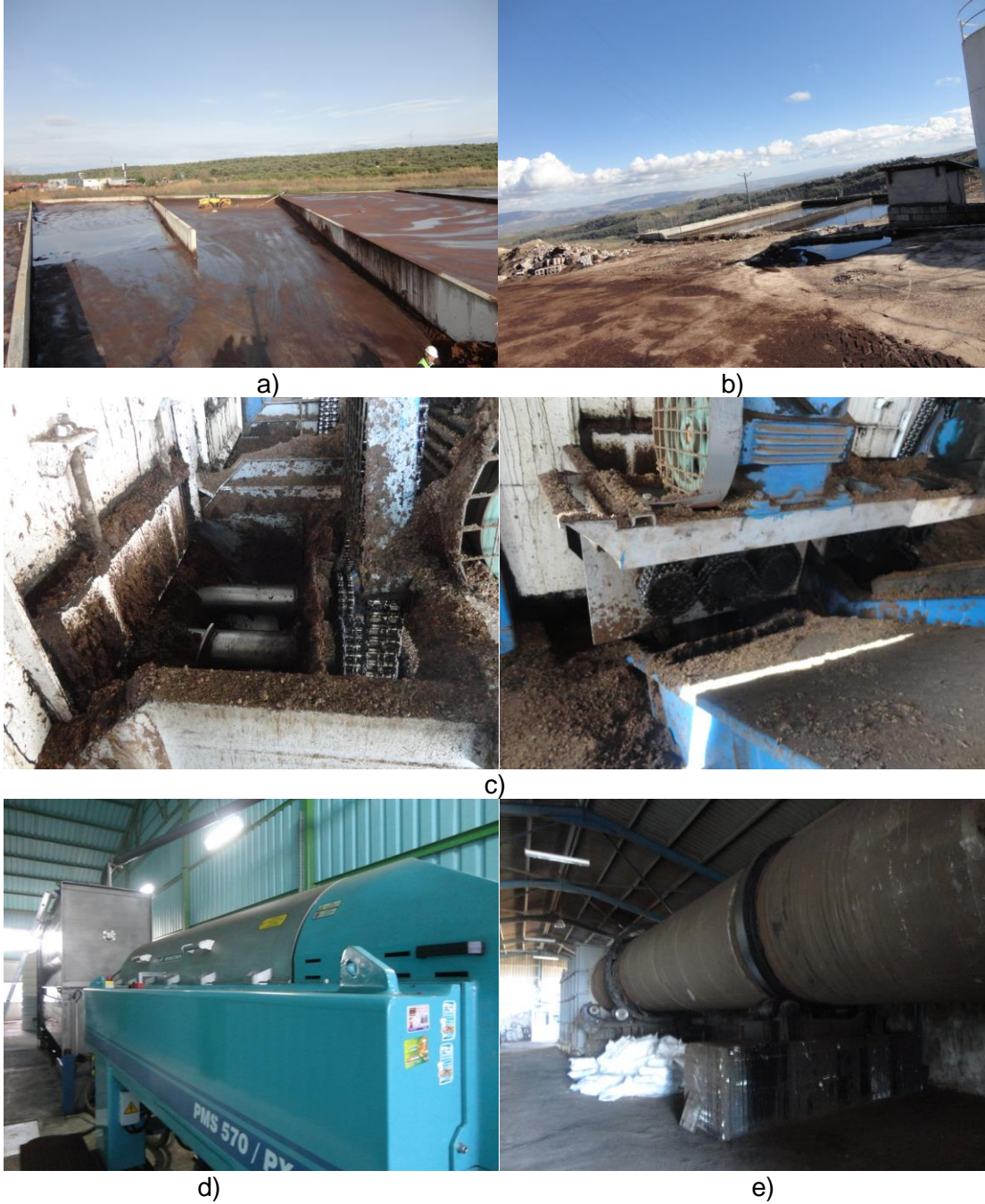
Şekil 63 Pirina tesislerinde iki fazlı pirina işleme yöntemi farklılıklarına göre yapılan yatırımlar a) Pirina havuzu b) atıksu havuzu c) karıştırma ünitesi d) 2. sıkım ünitesi e) kurutma ünitesi
