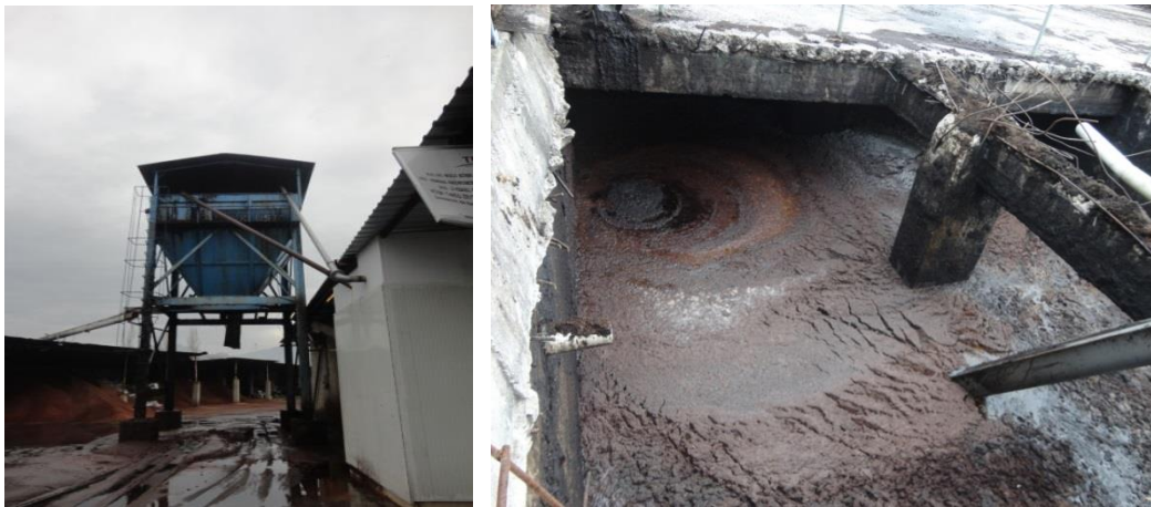
Şekil 55 Pirinanın depolanması a) Pirina depolama silosu b) Pirina havuzu
