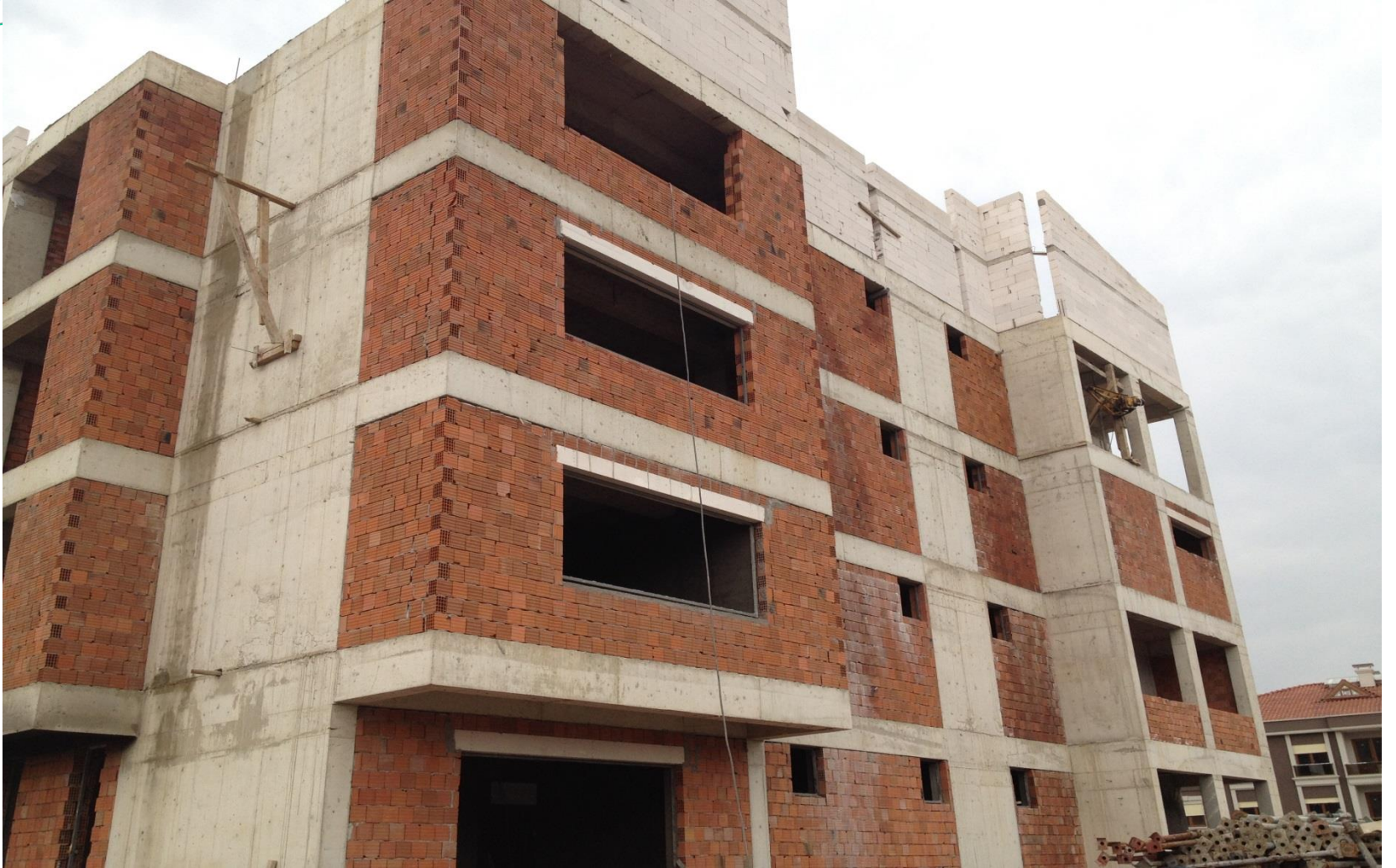
Hizmet Binası İnşaatı
