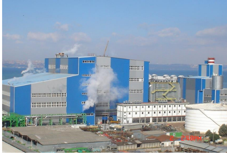
Resim C.1 – AKSA Termik Santrali(Çevre ve Şehircilik İl Müdürlüğü,2012)
