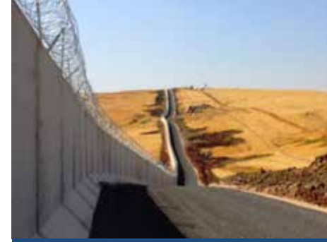
Şırnak Cizre Sınır Duvarı
