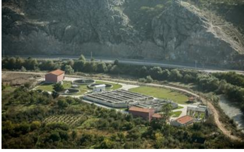
Şekil 9. Amasya Su ve Atıksu Projesi- Atıksu Arıtma Tesisi
