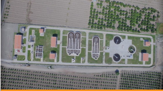
Hatay Erzin Atıksu Arıtma Tesisi
