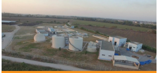
Ceyhan Atıksu Arıtma Tesisi
