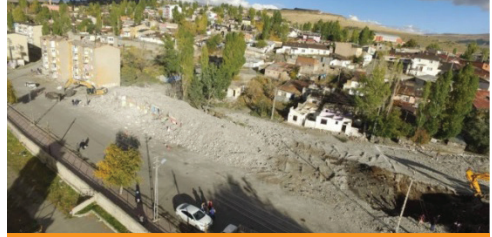
Erzurum Dağ Mahallesi Yıkım Çalışması
