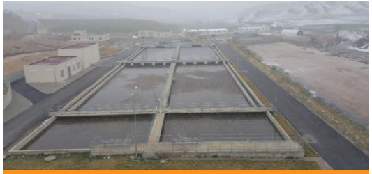
Adıyaman Atıksu Arıtma Tesisi
