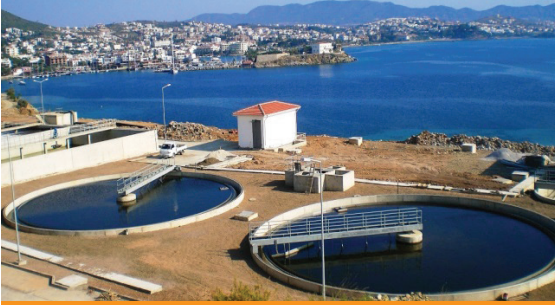
Datça (Muğla) Atıksu Arıtma Tesisi
