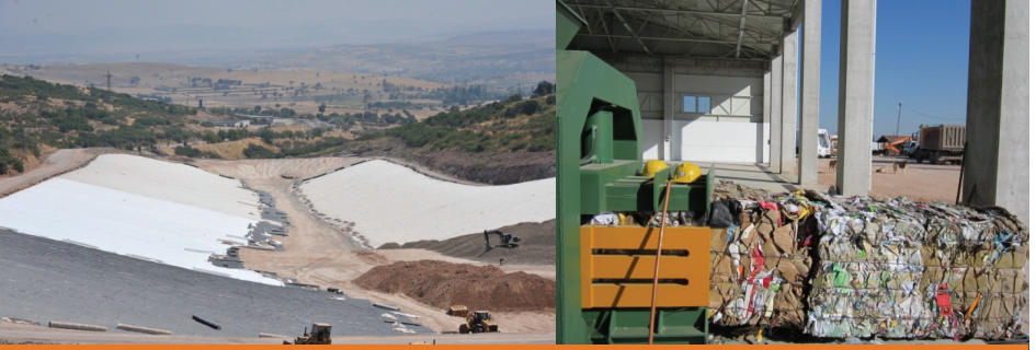
Balıkesir Katı Atık Düzenli Depolama Tesisi
