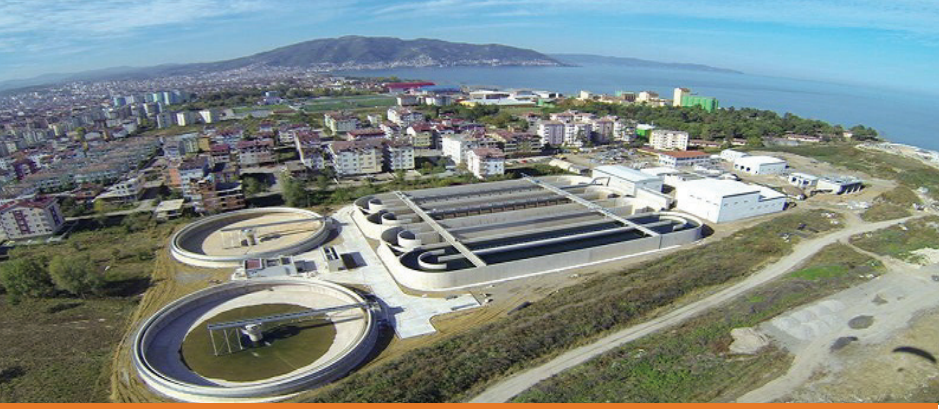
Ordu Atıksu Arıtma Tesisi
