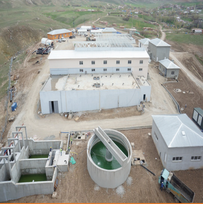
Doğubeyazıt İçmesuyu Temin Projesi
