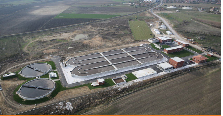
Lüleburgaz Atıksu Arıtma Tesisi
