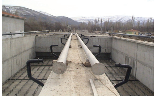
Atık Su Arıtma Tesisi
