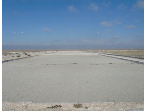
Altınekin Doğal Arıtma Tesisi
