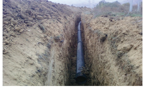
Kanalizasyon ve Kolektör Hattı Projesi
