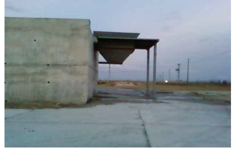
Eşmekaya Katı Atık Transfer İstasyonu
