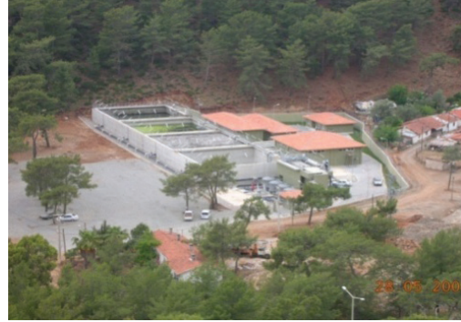
Göcek Atıksu Arıtma Tesisi
