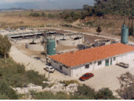
Dalyan Atıksu Arıtma Tesisi
