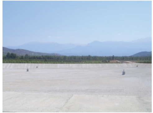
Fethiye Katı Atık Düzenli Depolama Tesisi
