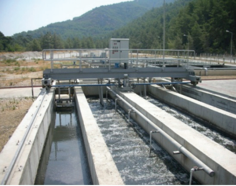
Akyaka-Gökova Atıksu Arıtma Tesisi
