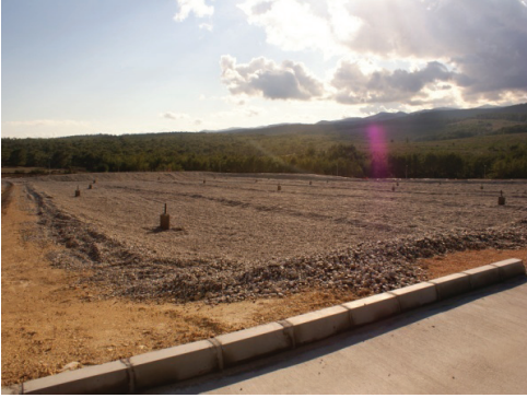
Göksu Katı Atık Düzenli Depolama Tesisi
