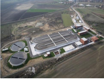
Şekil 9. Lüleburgaz Su ve Atıksu Projesi-Atıksu Arıtma Tesisi
