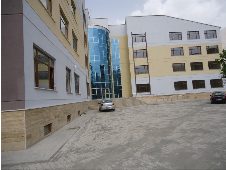
Hakkari Çevre ve Şehircilik İl Müdürlüğü Hizmet Binası
