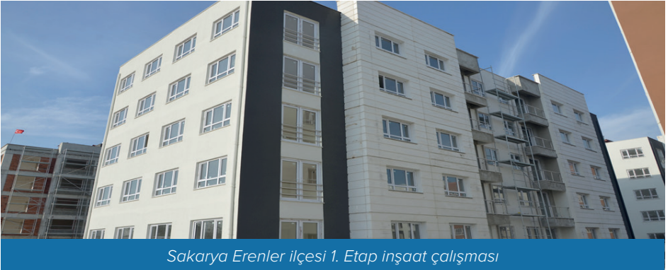
Sakarya Erenler İlçesi 1. Etap inşaat çalışması
