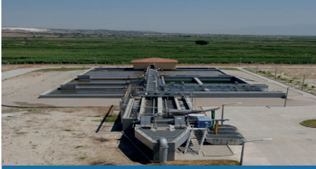
Pamukkale Atıksu Arıtma Tesis
