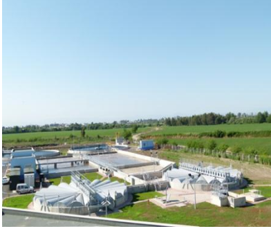
Şekil 17. Ceyhan Su ve Atıksu Projesi- Atıksu Atıksu Arıtma Tesisi
