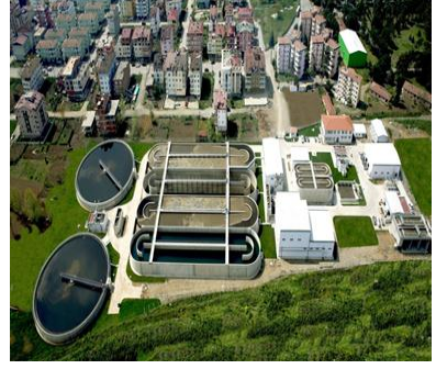
Şekil 18. Ordu Su ve Atıksu Projesi- Arıtma Tesisi
