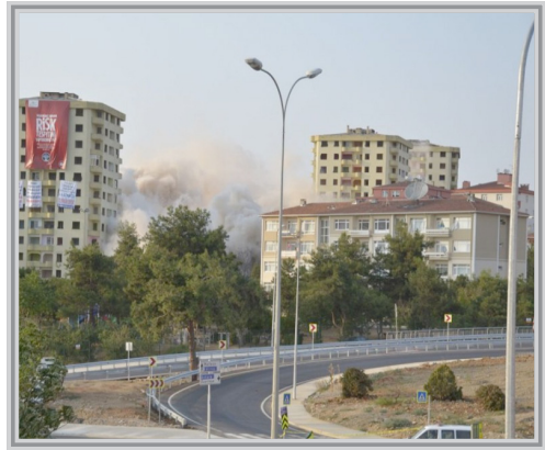
İstanbul Kartal Kontrollü Patlatmalı Bina Yıkımı (17.08. 2013)
