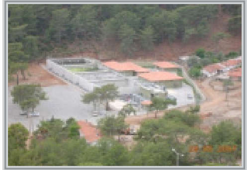
Göcek Atıksu Arıtma Tesisi
