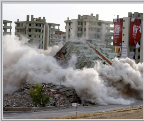
Ankara Sincan Kontrollü Patlatmalı Bina Yıkımı (17.08. 2013)
