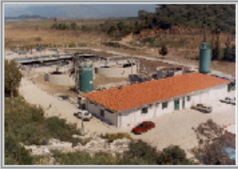
Dalyan Atıksu Arıtma Tesisi
