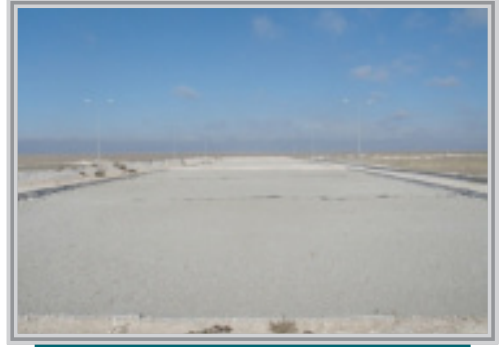
Altınekin Doğal Arıtma Tesisi
