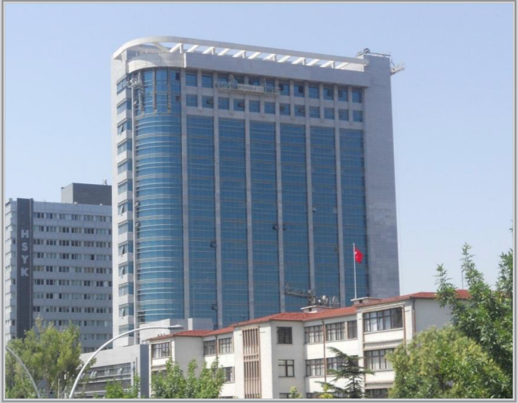
Türkiye İş Kurumu Genel Müdürlüğü Hizmet Binası
