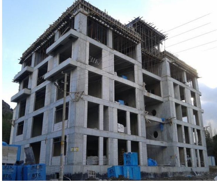
Şekil 11. Burdur Çevre ve Şehircilik İl Müdürlüğü
