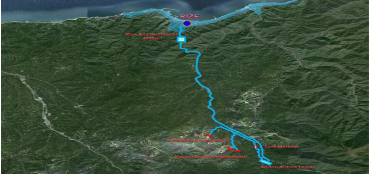
Rize İçmesuyu Projesi, Rize Merkez İçmesuyu İsale Hattı
