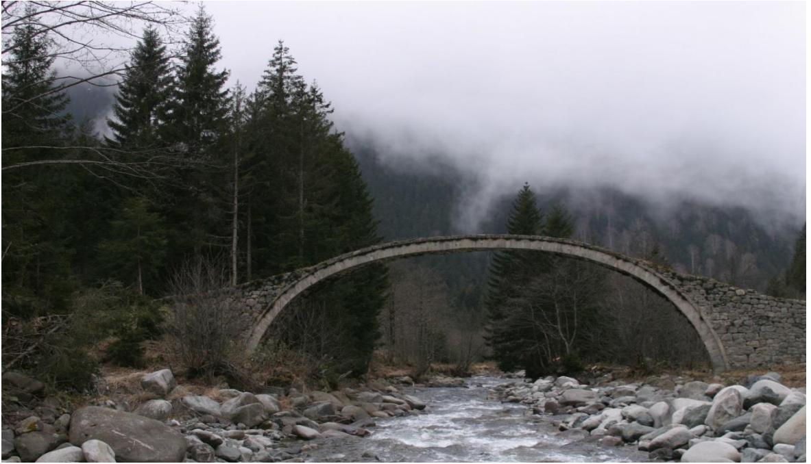
Çat (Çılanç) Köprüsü
