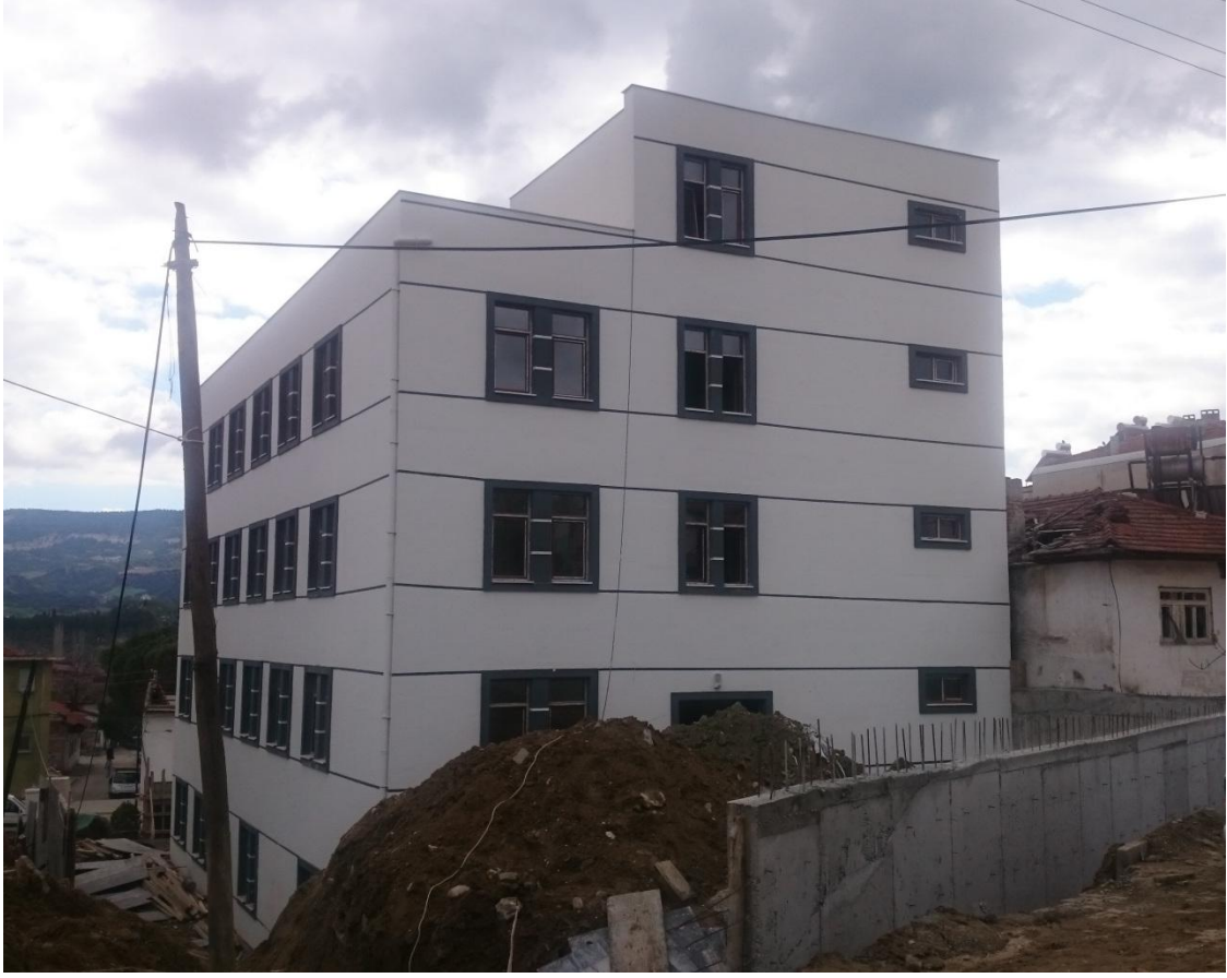
Manisa/ Selendi İlçe Gıda Tarım Müdürlüğü Hizmet Binası
