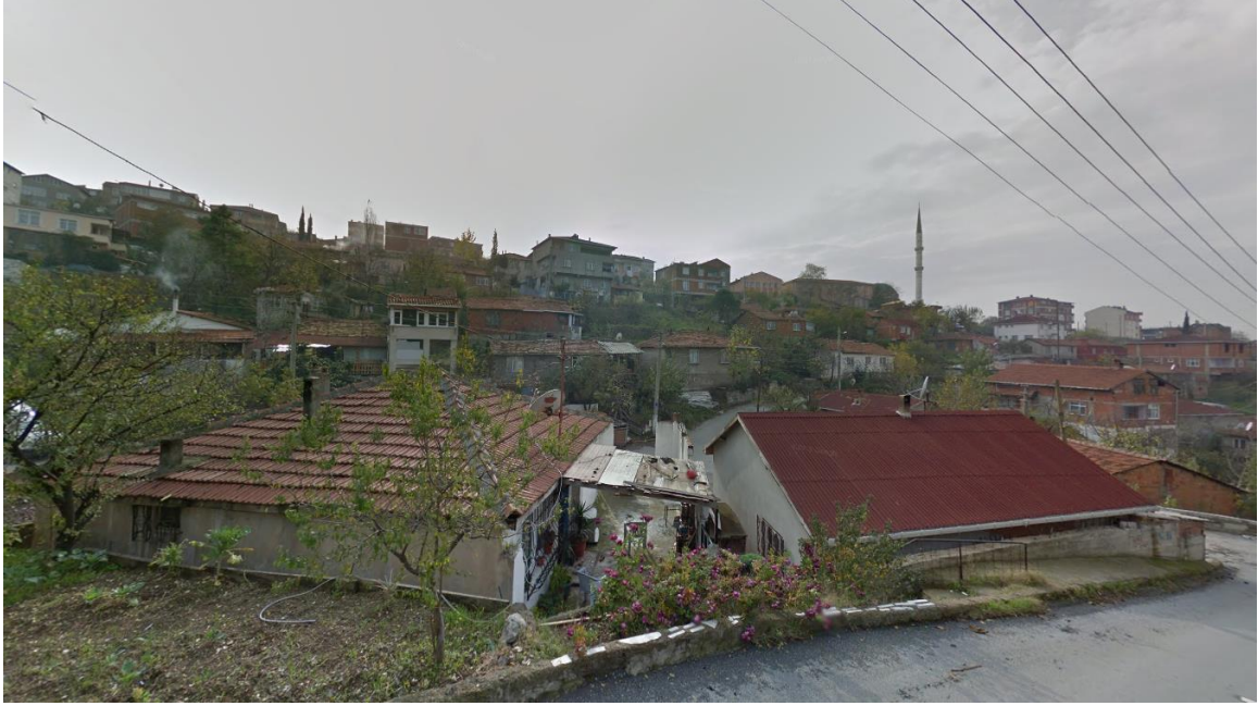
Şekil 6-3: Alan İçindeki Parseller ve Üzerindeki Yapılar
