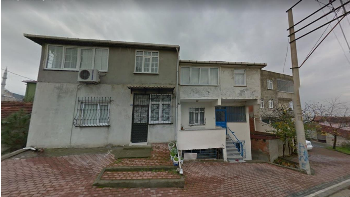
Şekil 12: Alan İçinden 2-3 Katlı Yapılar
