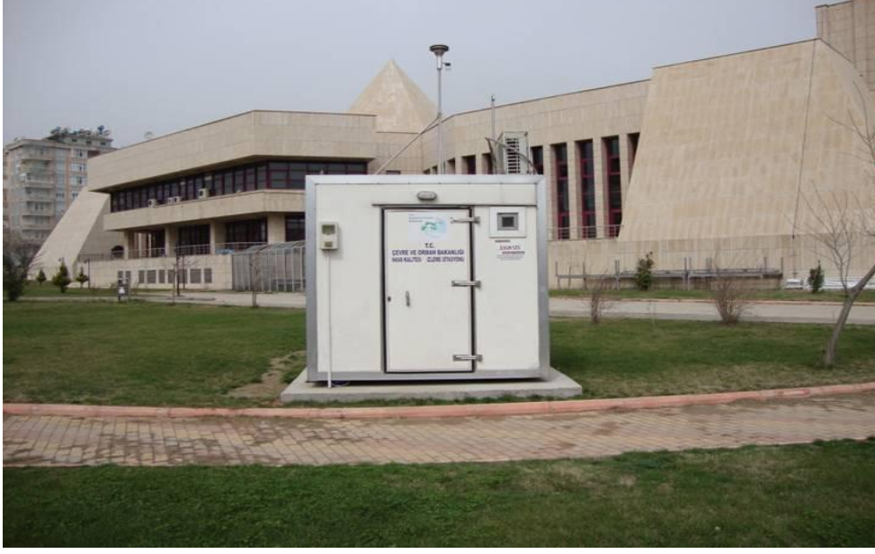
Şekil 3. 14. Merkez Hava Kalitesi İzleme İstasyonu
