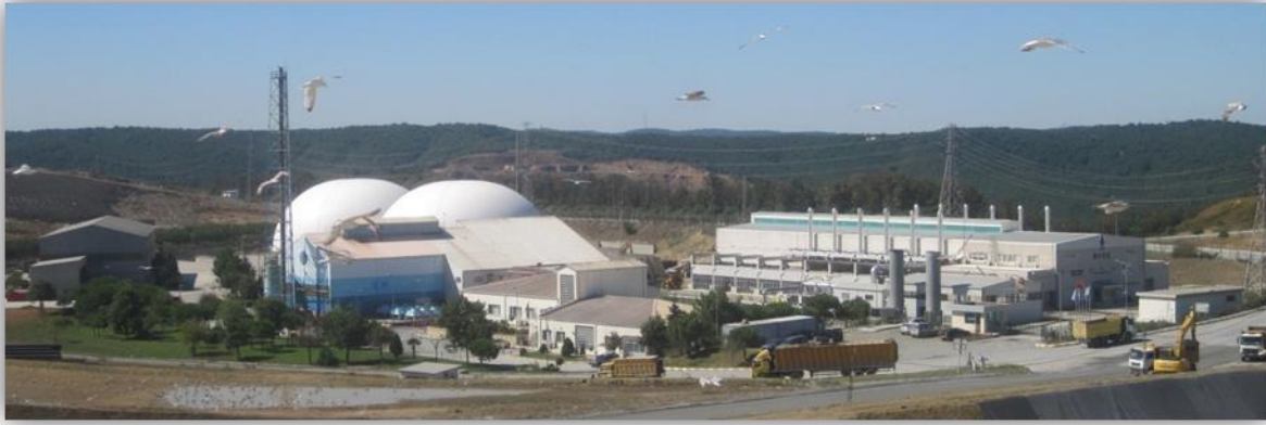
Resim D.4- Odayeri II. Sınıf Düzenli Depolama Tesis Enerji Üretim Tesisi
