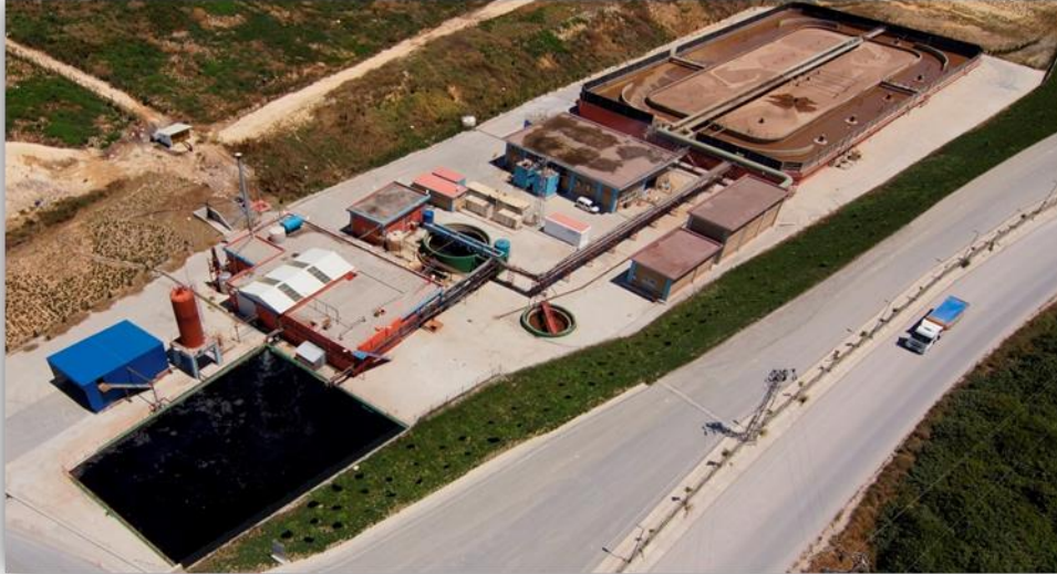
Resim D.3- Kömürcüoda II. Sınıf Düzenli Depolama Tesisi Sızıntı Suyu Arıtma Tesisi
