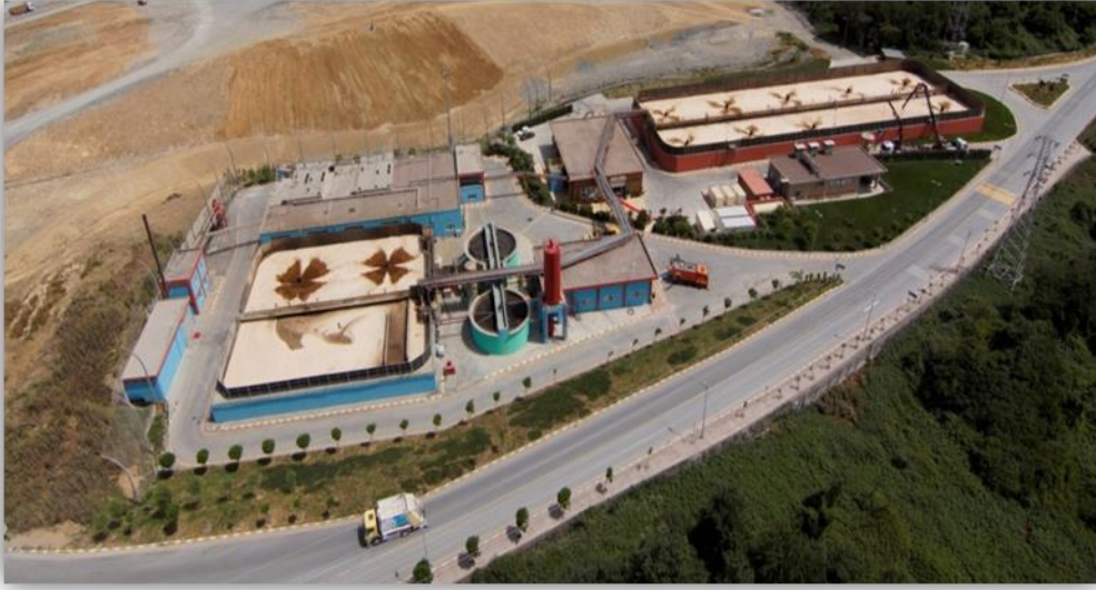
Resim D.2- Odayeri II. Sınıf Düzenli Depolama Tesisi Sızıntı Suyu Arıtma Tesisi
