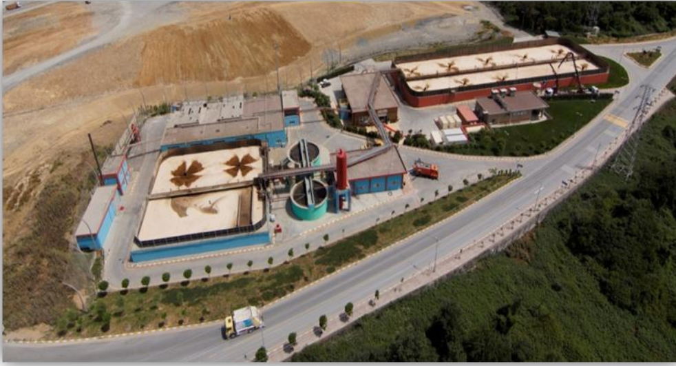
Resim D.2- Odayeri II. Sınıf D zenli Depolama Tesisi Sızıntı Suyu Arıtma Tesisi
