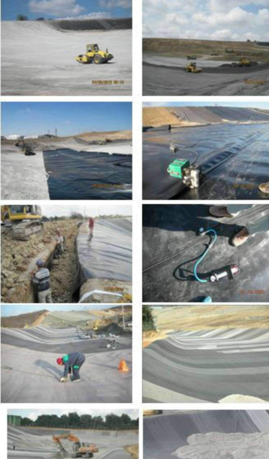
Resim C.1-2- Depo Tabanı Geçirimsizlik Sistemi Uygulama Görüntüleri
