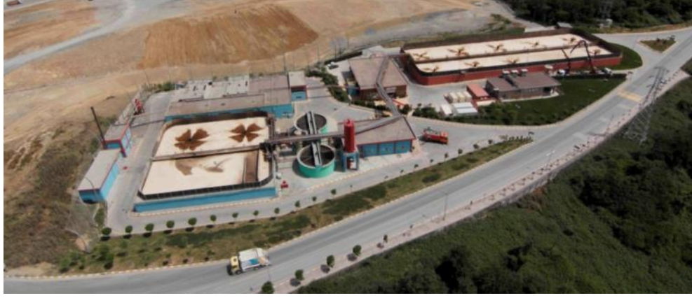
Resim C.3 - Odayeri II. Sınıf Düzenli Depolama Tesisi Sızıntı Suyu Arıtma Tesisi
