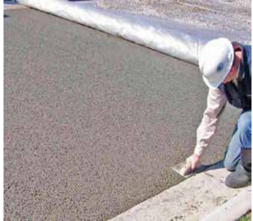
Şekil 9b: Geçirimli beton kaplamanın yerleştirilmesi ve sıkıştırılması - 1
