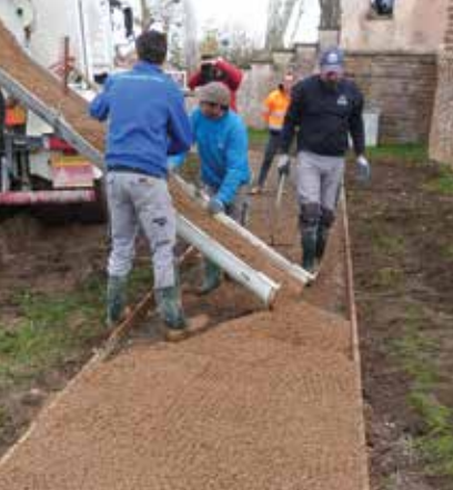
Şekil 9b: Geçirimli beton kaplamanın yerleştirilmesi ve sıkıştırılması - 1
