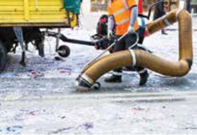
Şekil 13: Geçirimli beton kaplamaların vakumla temizlenmesi
