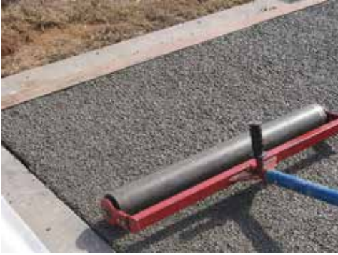
Şekil 10: Geçirimli beton kaplamanın yerleştirilmesi ve sıkıştırılması - 2
