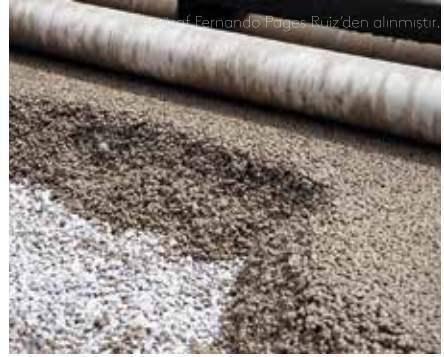
Şekil 10: Geçirimli beton kaplamanın yerleştirilmesi ve sıkıştırılması - 2
