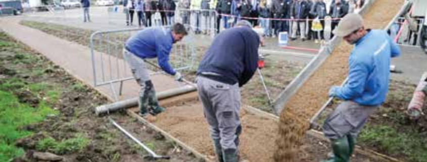
Şekil 9a: Geçirimli beton kaplamanın yerleştirilmesi ve sıkıştırılması - 1
