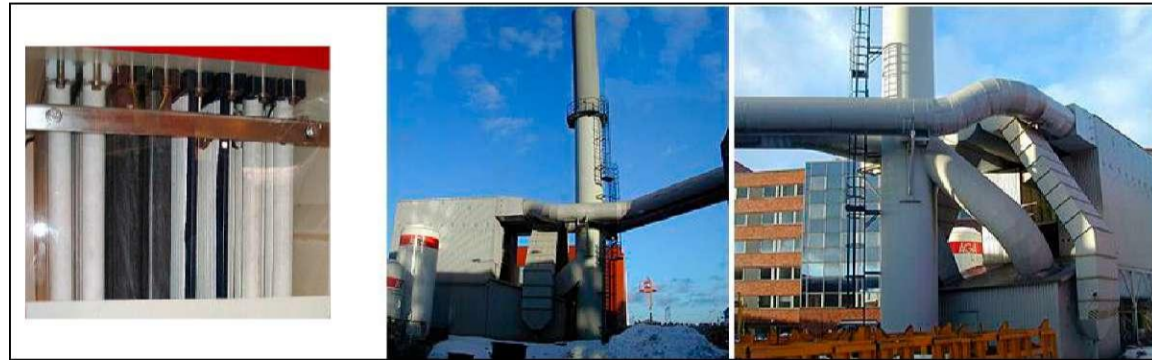
Şekil 4.10: Torba Filtre Üniteleri; İç (solda) ve Dış (sağda) Görüntüleri [237, HUT, 2003]
