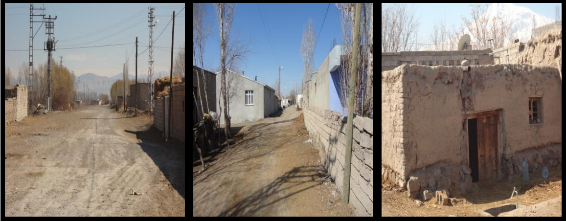
EK-4 Resim Görüntüsü 1: Aralık İlçesi Öneri Bölgeleri Mevcut Durum Fotoğrafları (Nisan 2012) Aralık İlçesi İmar Plansız Alan İçerisinde Kalan Öneri Alanlar Resim Görüntüleri:
