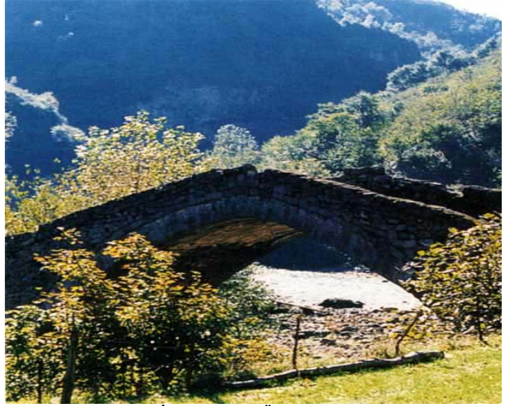
Şekil A.18 . Yağlıdere İlçesi Kemer Köprü
