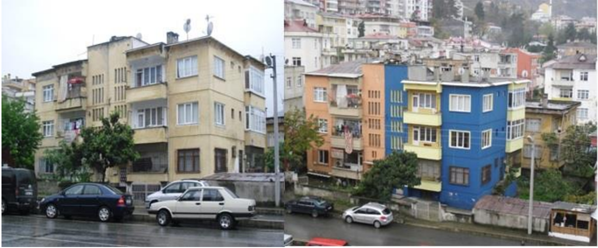
Fotoğraf H.2-Boyasız ve Sivasız Bina Çalışmaları
