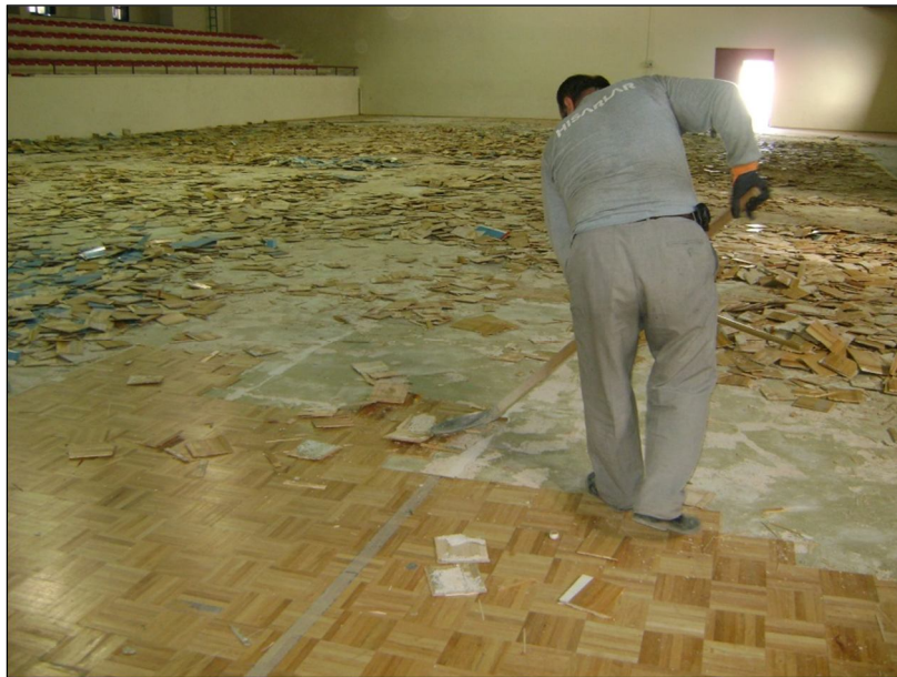
Mevcut sahadaki mozayik parke kaplama kazınarak sökülüştür.
