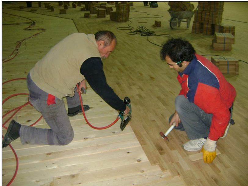
Tahta kaplamaların üzerine parkelerin montajı.
