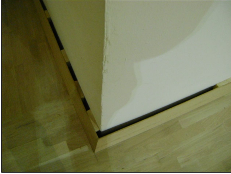
Süpürgeliklerin takozla duvara sabitlenmesi. (Hava sirkülasyonu için boşluklu yapılmaktadır)
