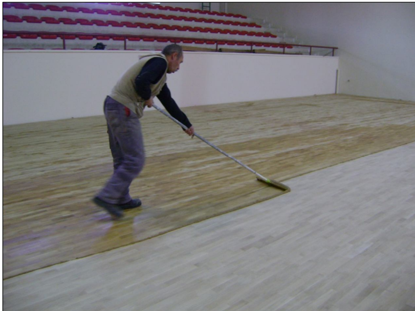
Tutkal ve 100 numara silim tozuyla yapılan dolgu macunu imalatının yapılması
