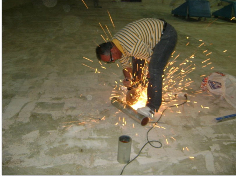
Voleybol direkleri için galvaniz borudan mapa yapılması.
