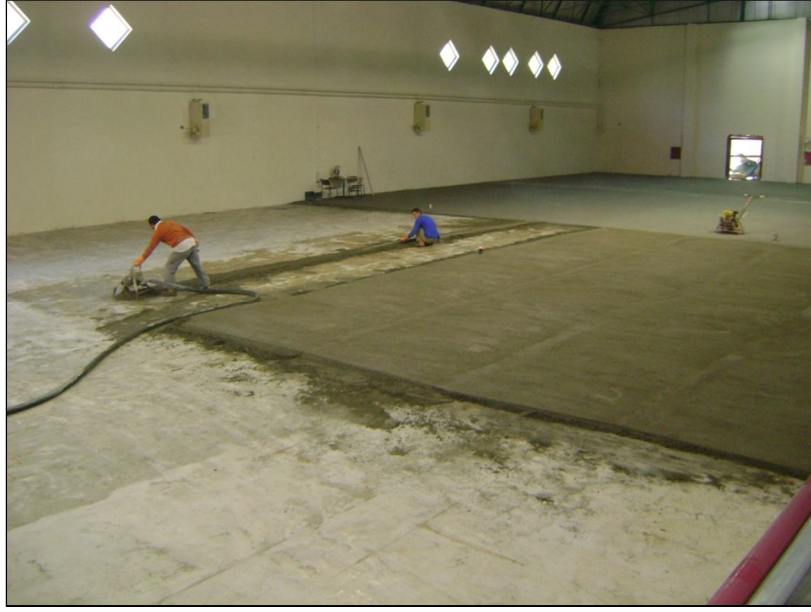
Lazer kotla milimetrik kot alınarak sahada tesfiye betonu dökümü.
