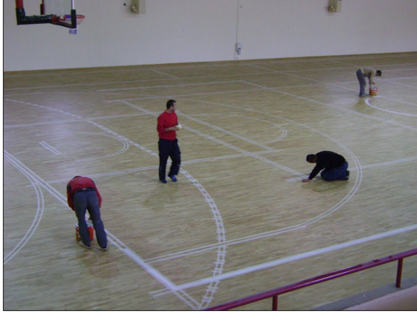
Saha çizgilerinin (Volebol, Basketbol ve Hentbol) çizilmesi.
