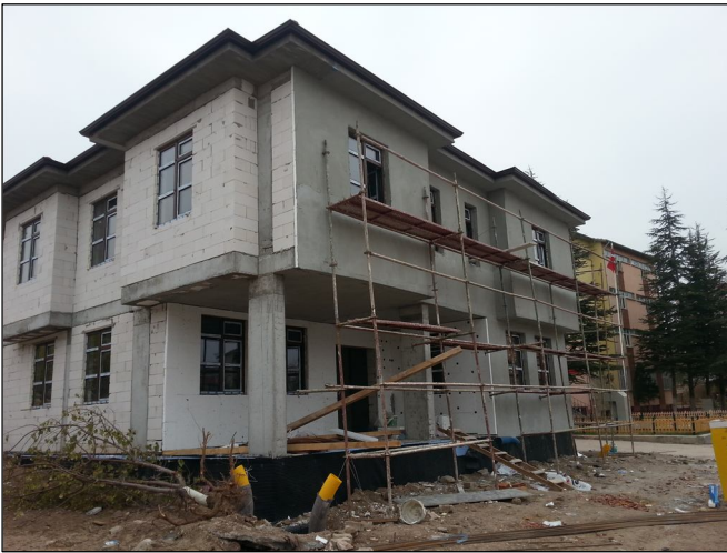
Resim 16-17. Binaların dış cephesine 6 cm EPS kaplama malzeme ile ısı yalıtımı yapılması.
