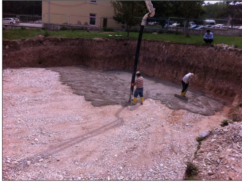
Resim3. Sıkıştırılmış stabilize malzemenin üzerine yalıtım altı grobeton dökülmesi
