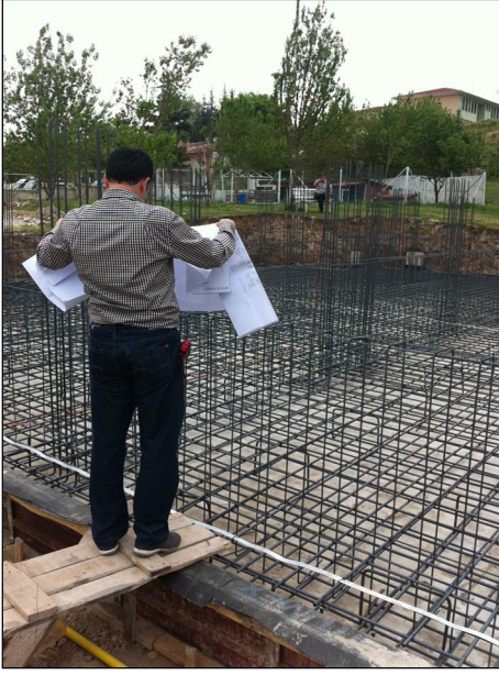
Resim6-7. Radyejeneral temel sistemini betonarme uygulama projesi ile kontrol edilmesi ve beton döküm aşamaları.
