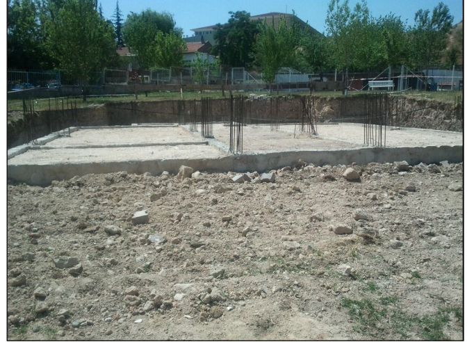
Resim8-9. Subasman altı betonarme perdelerinin imal edilmesi ve içlerinin stabilize dolgu malzemesi ile kompaktör yardımıyla sıkıştırılarak doldurulması.
