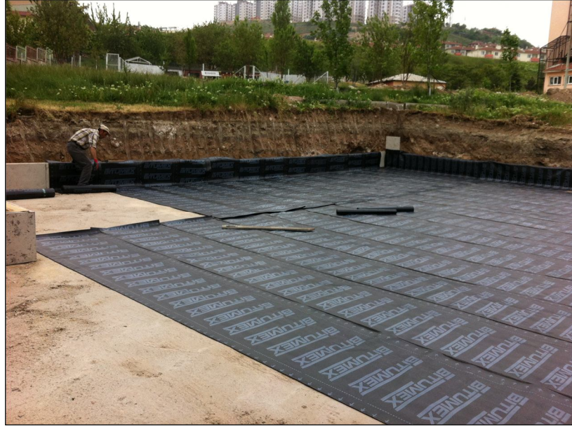
Resim4. Grobeton üzerine iki kat polyester keçe taşıyıcılı 2 kat (3 mm) su yalıtım malzemesinin temeli bohçalayacak şekilde yapılması.
