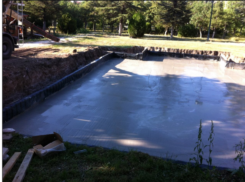
Resim5. Su yalıtım malzemesinin üzerine koruma betonu (grobeton) dökülmesi
