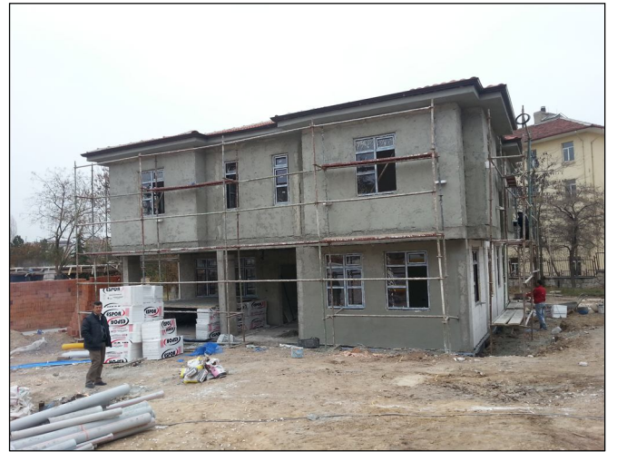
Resim 16-17. Binaların dış cephesine 6 cm EPS kaplama malzeme ile ısı yalıtımı yapılması.
