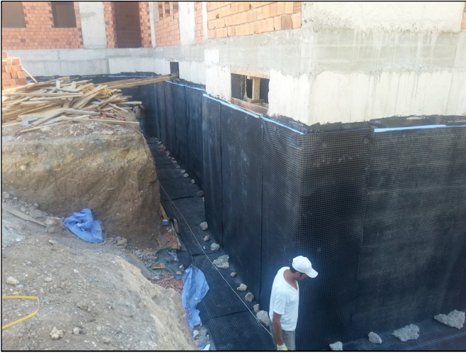
Resim12. Subasman altı betonarme perdelerde iki kat su yalıtımı (bohçalama) üzerine 5 cm XPS ısı yalıtımı malzemesi, üzerinede PVC Drenaj levhası ile koruma amaçlı imal edilmiştir.
