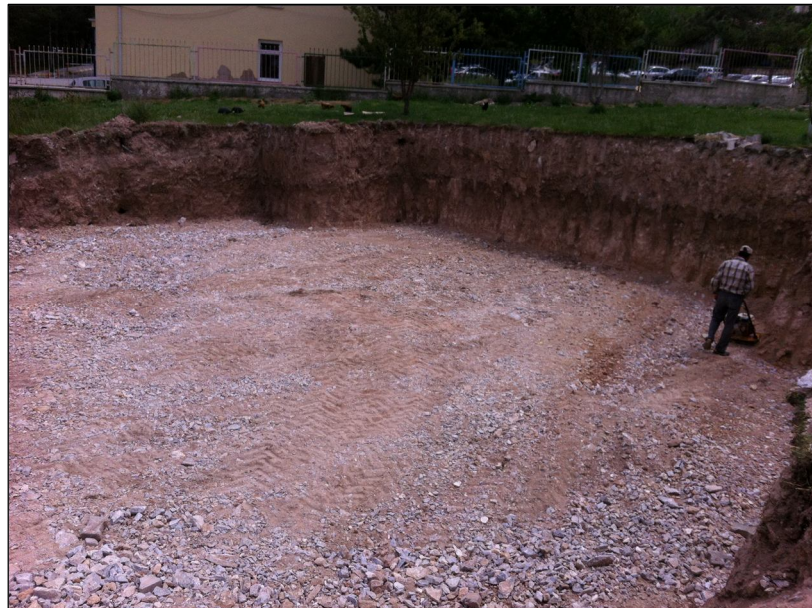
Resim2. Temel altına stabilize malzemenin serilerek sıkıştırılması
