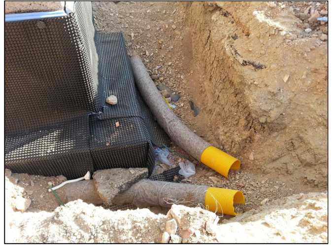
Resim12. Subasman altı betonarme perdelerde iki kat su yalıtımı (bohçalama) üzerine 5 cm XPS ısı yalıtımı malzemesi, üzerinede PVC Drenaj levhası ile koruma amaçlı imal edilmiştir.
