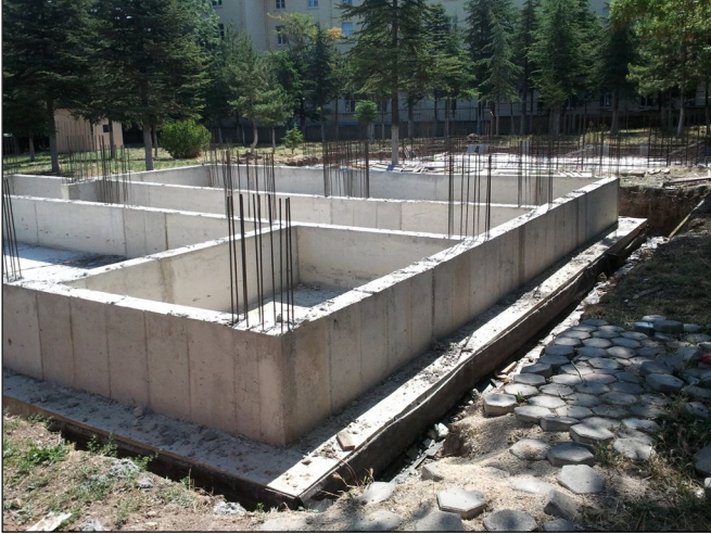
Resim8-9. Subasman altı betonarme perdelerinin imal edilmesi ve içlerinin stabilize dolgu malzemesi ile kompaktör yardımıyla sıkıştırılarak doldurulması.
