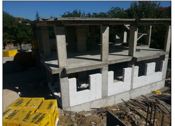
Resim 10-11. Zemin ve 1. Normal kat beton döküm aşamaları.
