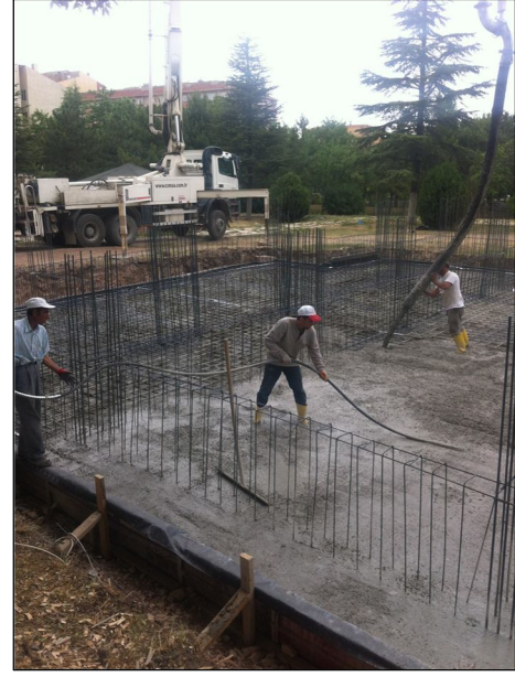
Resim6-7. Radyejeneral temel sistemini betonarme uygulama projesi ile kontrol edilmesi ve beton döküm aşamaları.
