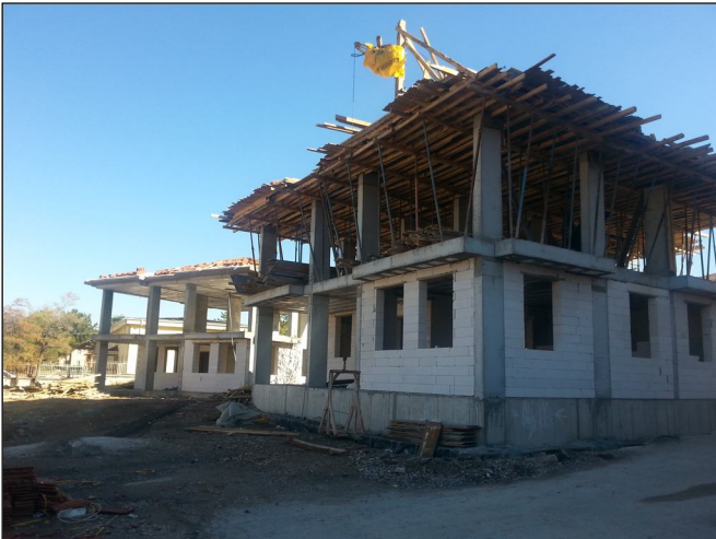
Resim 10-11. Zemin ve 1. Normal kat beton döküm aşamaları.
