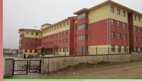
Vadişehir 24 Derslik Lise
