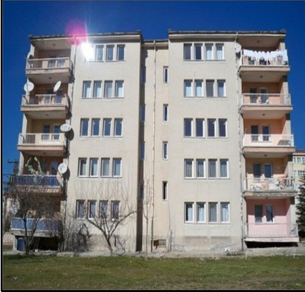
Lojman Binası-Çankaya Mah.
