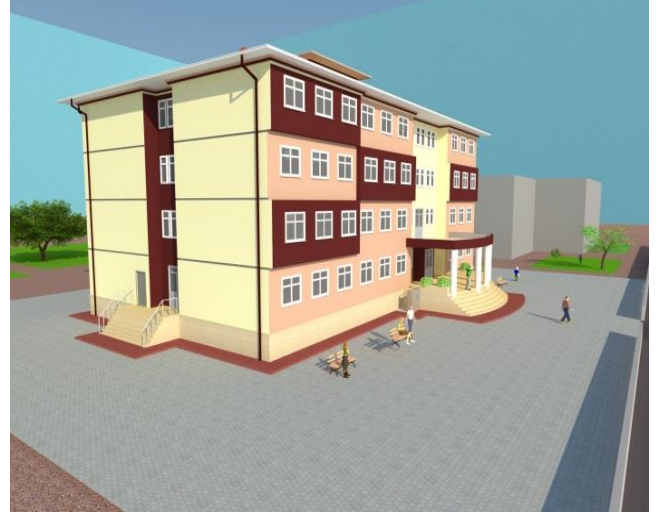
Halk Eğitim Binası
