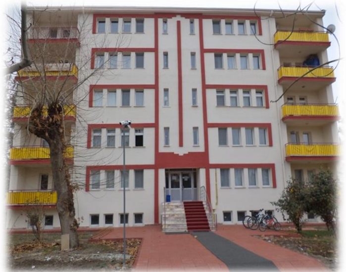
Lojman Binası-Hoşnudiye Mah.
