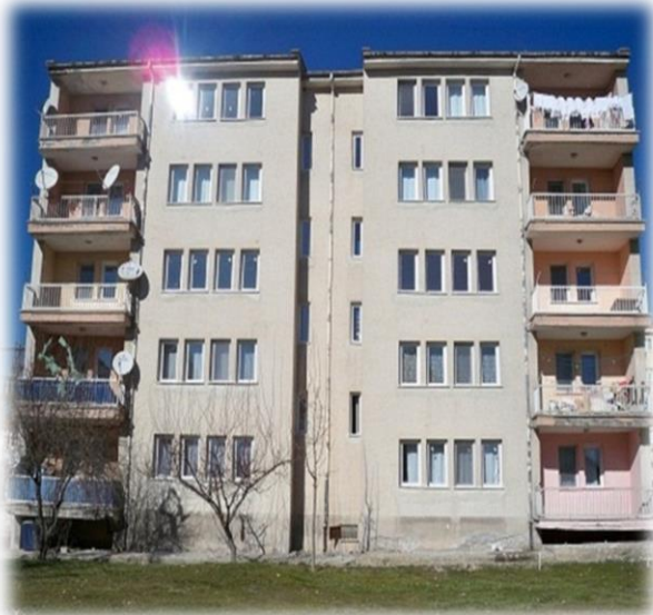
Lojman Binası-Çankaya Mah.
