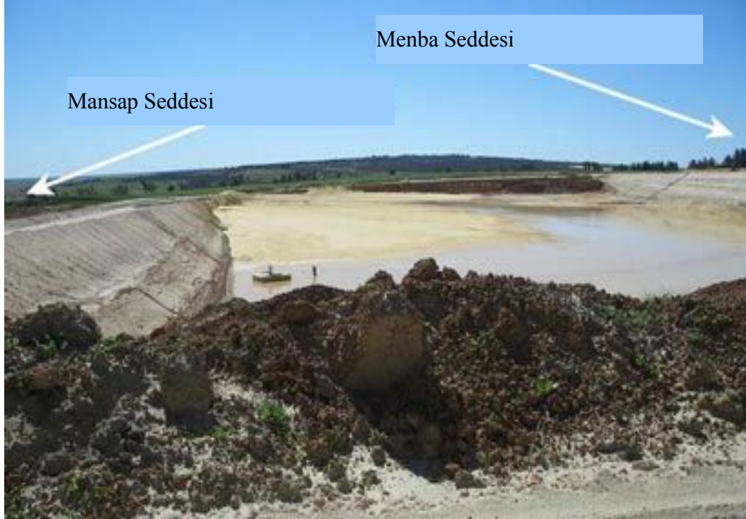
Şekil 3.5 : Vadi Tabanının Eğimi Yönüne Paralel Atık Barajı Görünümü
