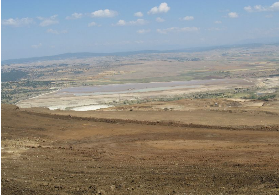
Şekil 2.11 : Eti Gümüş Halka Şekilli Atık Barajları
