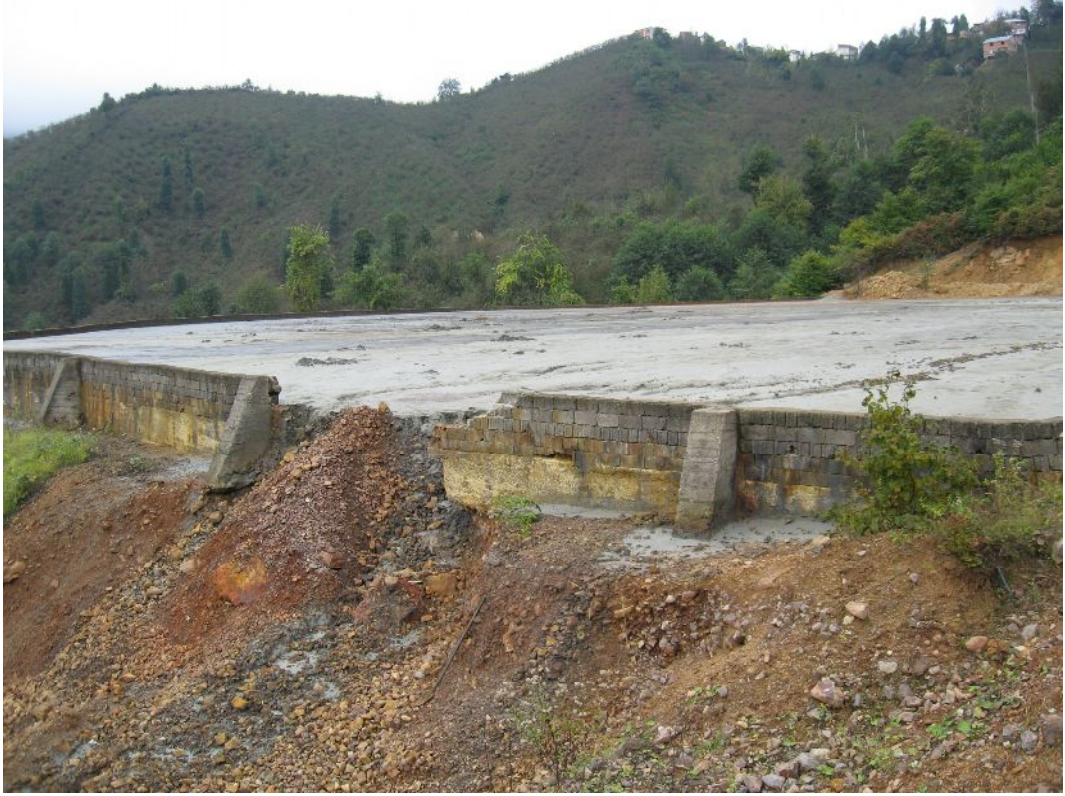
Şekil 2.5 : Lahonos Eski Atık Barajı
