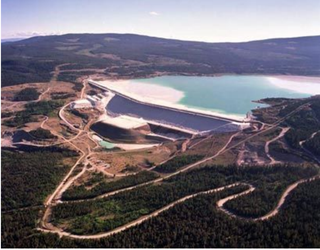
Şekil 3.4 : Vadi Tabanının Eğimi Yönüne Dik Atık Barajı Görünümü
