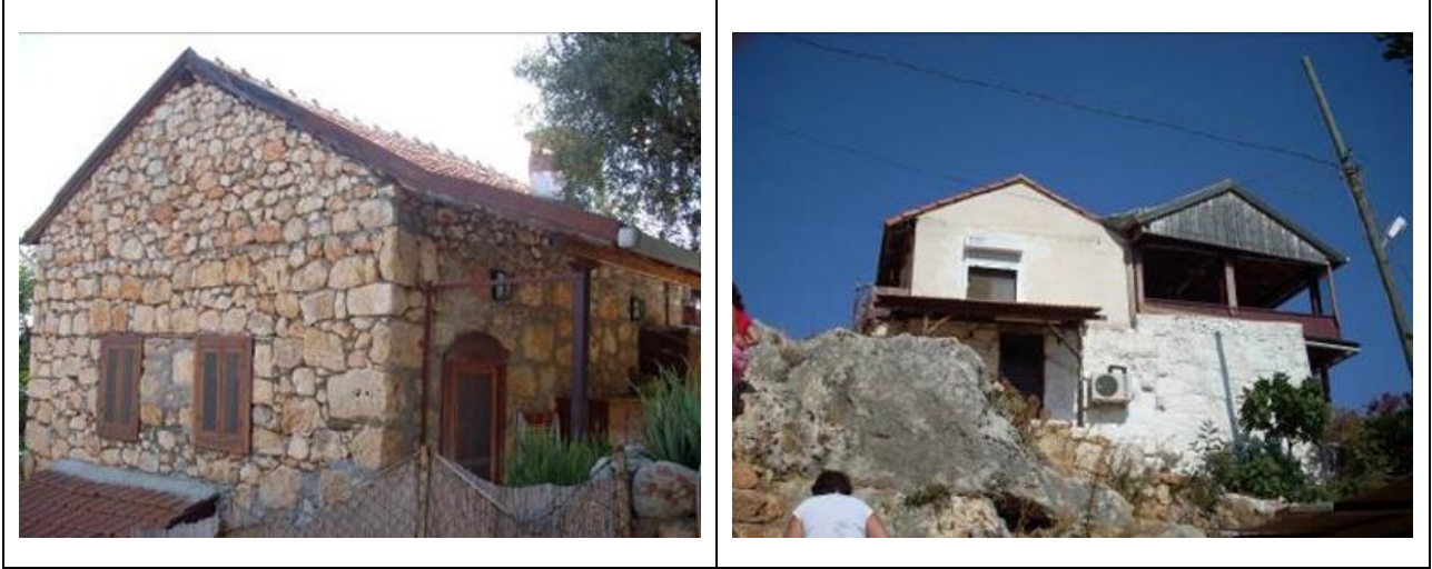
Fotoğraflar 4.2.2.4. Kale Mahallesi Restorasyon Uygulamaları
