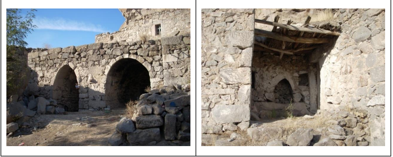
Fotoğraflar 4.2.2.3.8. Belisırma: Envanter No: 4, Alt Kotta Bulunan Servis Mekanları, Yaşam Birimlerine Girişi Sağlayan Yarı-Açık Mekan
