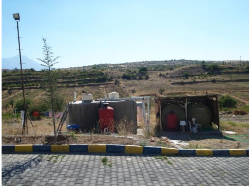
Fotoğraf 2.3.6.1.4. Sıcak suyun termal tesise ulaştığı ve sıcak suyun gazının uzaklaştırıldığı su tankları.
