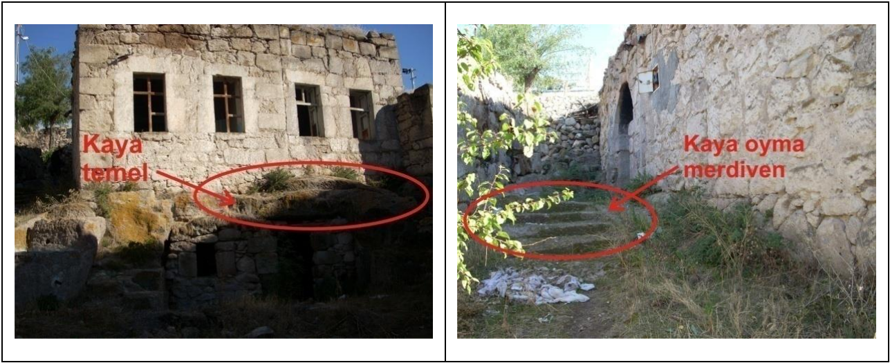
Fotoğraflar 4.2.2.3.4. Kaya Oluşumun Yapı Temeli ve Avlu Elemanı Olarak Kullanılması (Envanter No:1)
