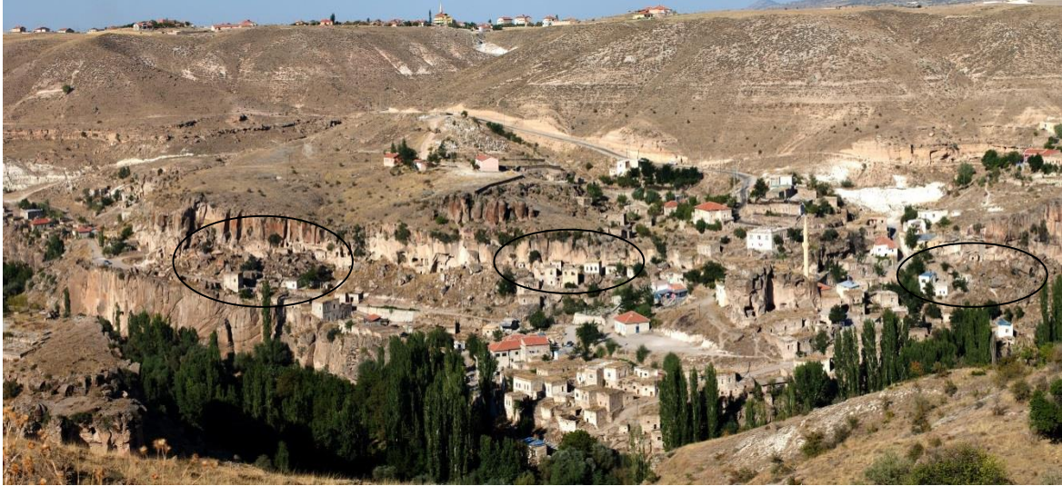
Fotoğraf 2.3.8.6. Belisırma Köyü İçinde Görülen Kaya Düşmeleri ve Kaya Düşmesi Tehdidi Altındaki Evler
