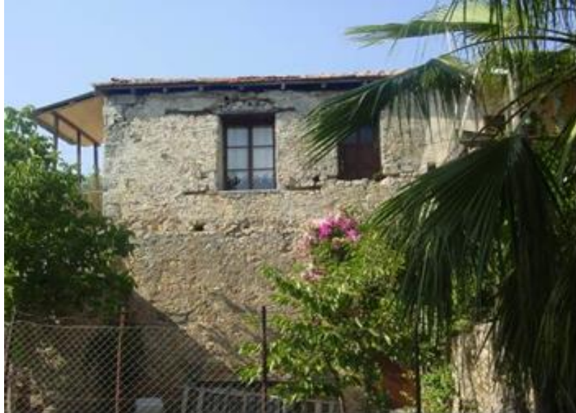
Fotoğraflar 4.2.1.4.3. Keçiler Köyü’nde “Şarap Evi” Olarak Onarılmış Geleneksel Yapı
