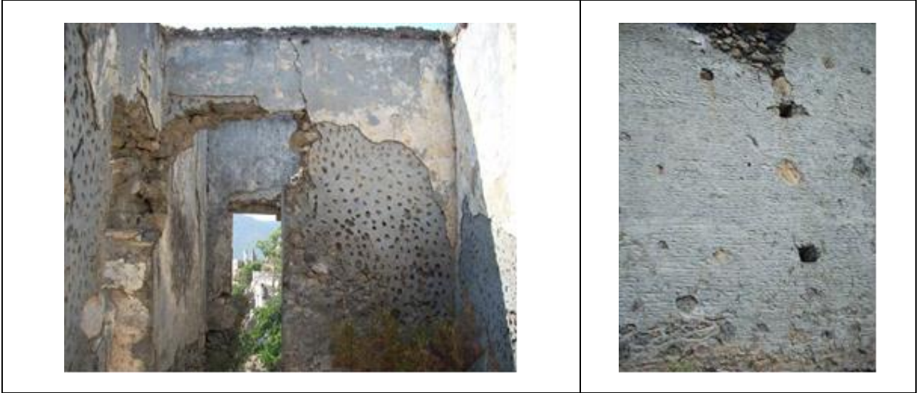
Fotoğraflar 4.2.1.3.5. Kayaköy Geleneksel Konutlarında Sıva Uygulamaları
