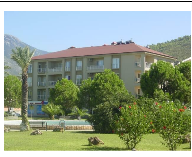
Fotoğraf 4.2.1.1.5. Fethiye’nin Kuzeyinde Sahil Şeridine Yakın Kısımlarda Yeni Yapılaşma Kurallarına Göre İnşa Edilmiş Bir Apartman
