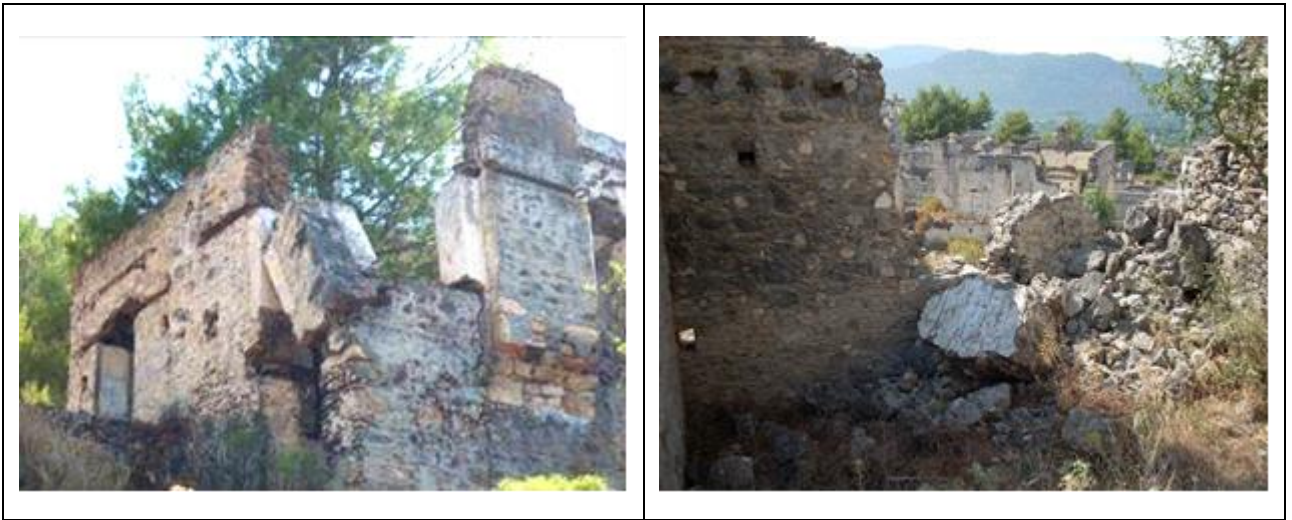
Fotoğraflar 4.2.1.3.6. Kayaköy Geleneksel Yapılarında Önemli Yapısal Bozulmalar
