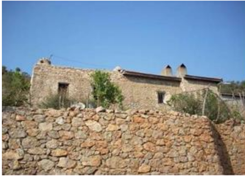
Fotoğraflar 4.2.1.4.4. Keçiler Köyü’nde Satılık Durumda Olan Metruk Geleneksel Yapılar ve Onarılmış Örnekler
