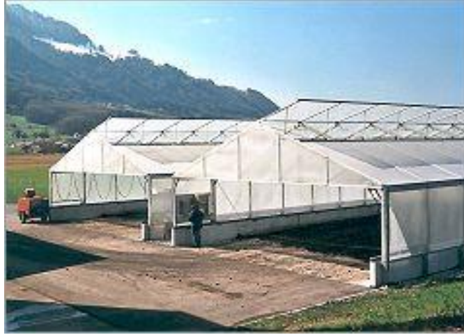
Şekil 4.2. Üstü kapalı çamur kurutma yatakları ( http://www.ist-anlagenbau.de )
