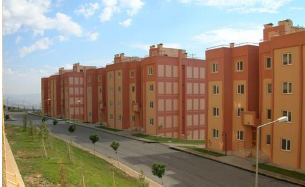
Kahramanmaraş Serintepe 80 Konut ve Altyapı
