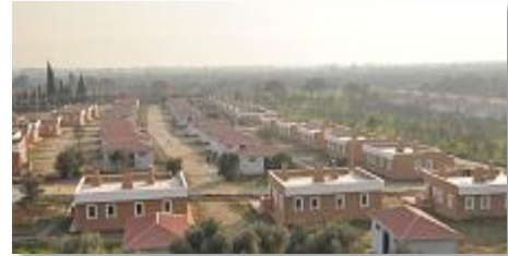
Aydın İkiçidere Barajı İskânı 75 konut- İşletme ve Altyapı
